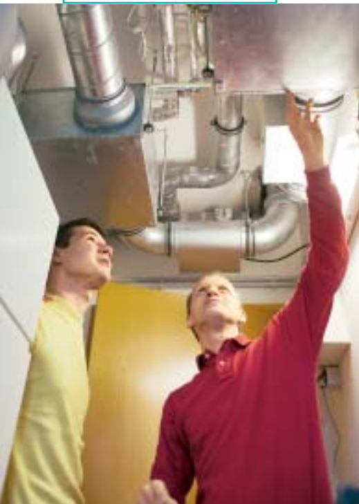
Warm genug. Bernd Fischer mit Sohn Arne im Technikraum seines Passivhauses. Hier wird die Frischluft von der Abluft angewärmt und bei Bedarf von einer Wärmepumpe nachbeheizt.
