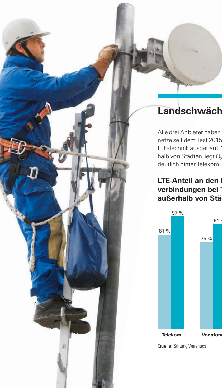
Netzausbau. Ein Techniker bei der Arbeit am Funkmast.
