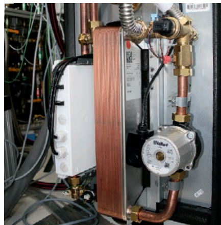
Wärmetauscher. Er überträgt die Speicherwärme aufs Trinkwasser (Vaillant).
