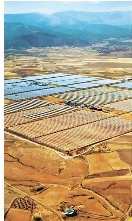
Das Solarkraftwerk Andasol der Solar Millennium AG bei Villanueva de la Serena in Spanien.
